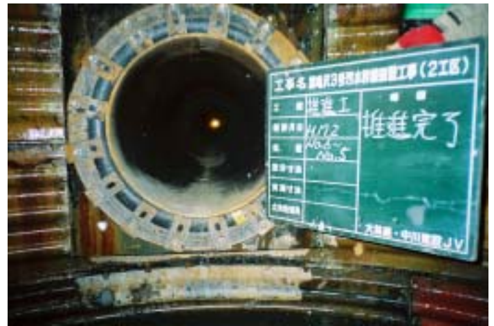
写真 - 4 推進完了後の管内
