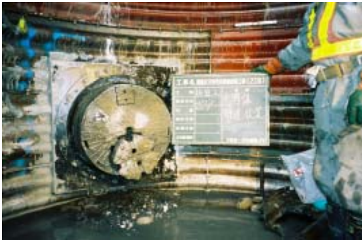
写真 - 3 先導体到達（推進距離 86.6m後）
