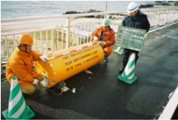
写真 - 1 ハードロック工法先導体
