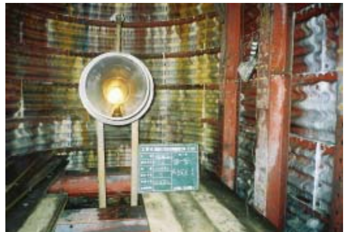
写真 - 6 本管布設完了
