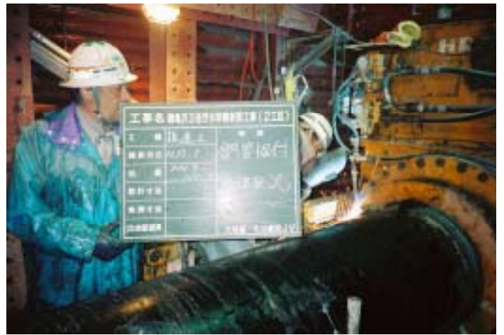
写真 - 2 推進管（鋼管）溶接接続
