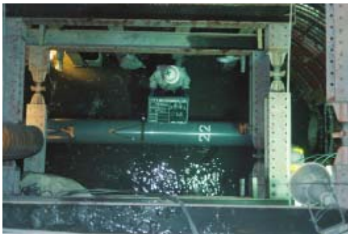
写真 - 5 本管（塩ビ管）挿入
